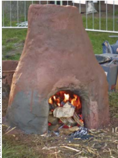
Nachdem der Ofen errichtet ist, wird er mit einem Holzfeuer vollständig getrocknet
